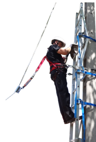
8. Kép :Második létraelem rögzítése
